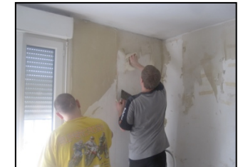
Réhabilitation de logements
